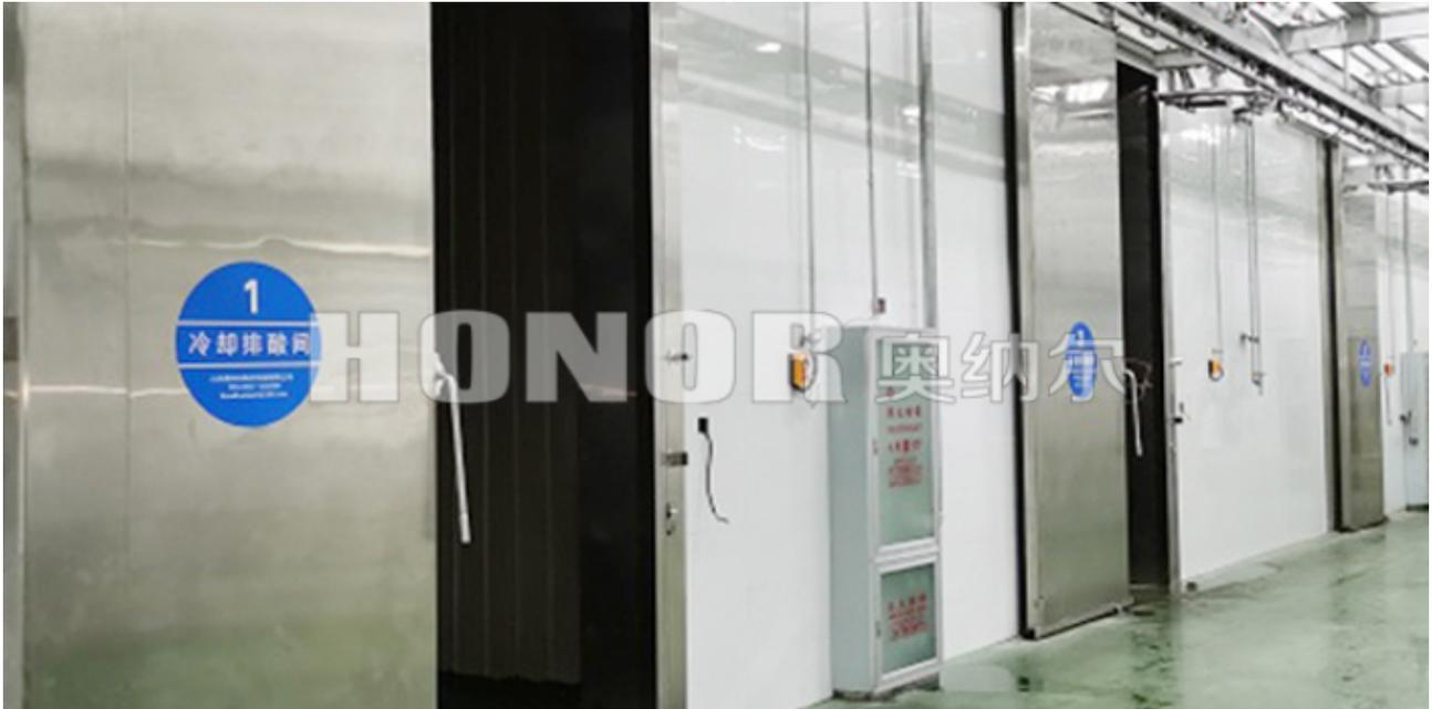
通常我们在食品冷库设计与建造时的冷库门选型和设计时，首先根据库内库外的温度差，超过60℃时一般选用120~150mm厚度，超过此厚度则无太大实际意义，因为此时密封条的传导散热是冷量损失的主要因素。MTH的做法是增加第密封条，这样能很好的保障冷库门的密封性。食品冷库设计与建造时可选择的冷库门面板的材质主要有喷涂彩钢板、不锈钢、玻璃钢、ABS、PE、铝板等，面板材质的选择主要根据使用的环境，普通环境喷涂彩钢板（彩钢板的质量要过关）即可满足要求，其中不锈钢等材质主要用于食品厂、海鲜类、或其它有一定腐蚀的环境。ABS、PE、玻璃钢等是近几年新兴的材质，具有耐腐蚀、防碰撞、重量轻的优点。奥纳尔制冷科技奉创新为立业之本。云南洁净门价格
